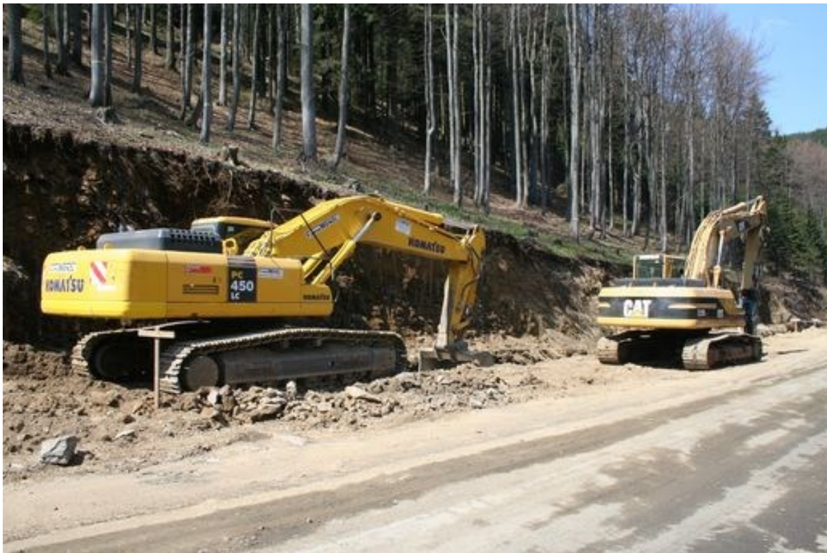
Obrázek 21: Výkop v trase (odvodnění)
