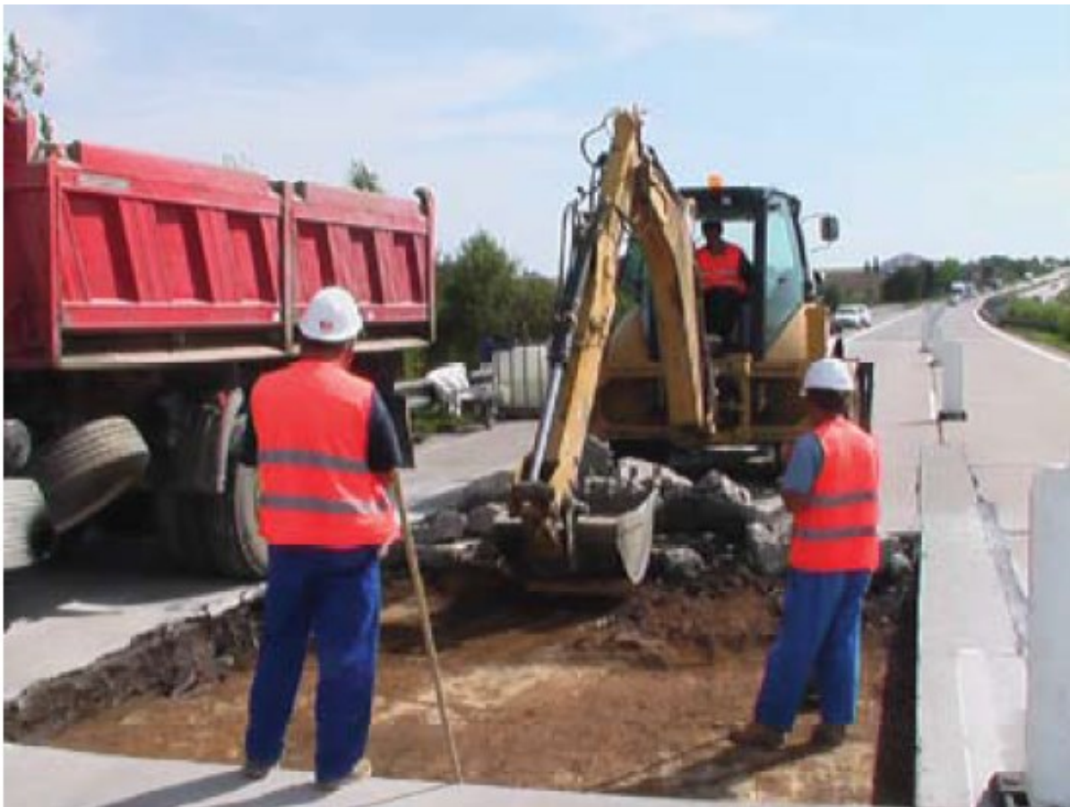
Obrázek 02: Odstranění staré CB desky
