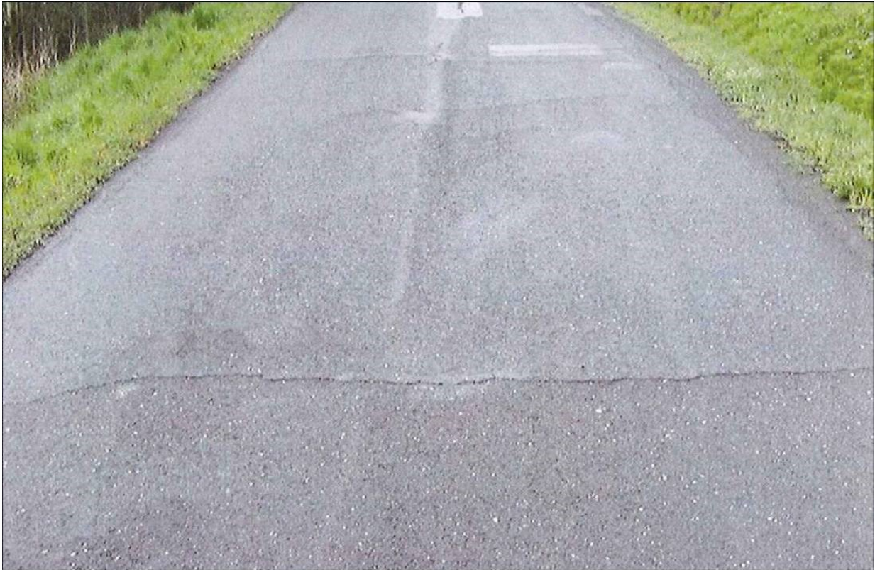
Obrázek 15: Mrazové trhliny
