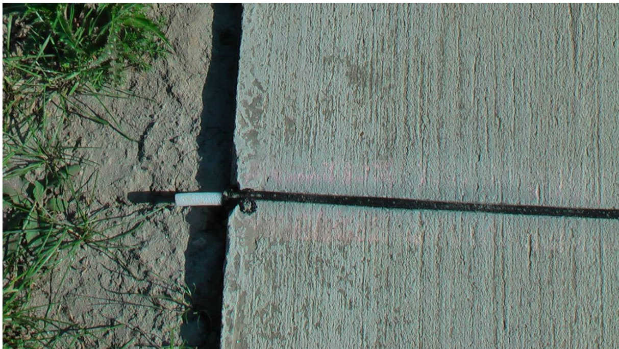
Obrázek 09: Těsnění spáry pomocí pryžového profilu
