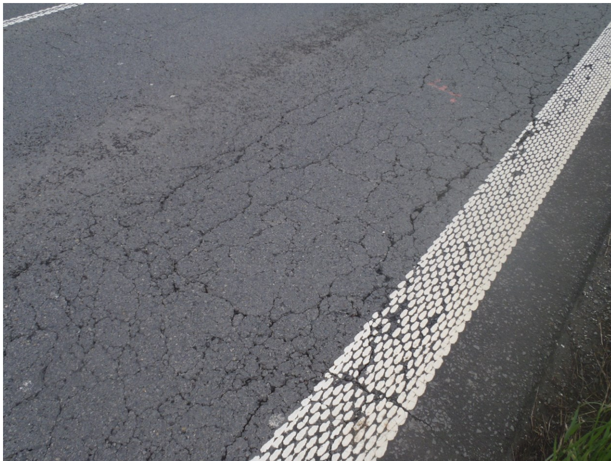
Obrázek 20: Sít'ové trhliny
