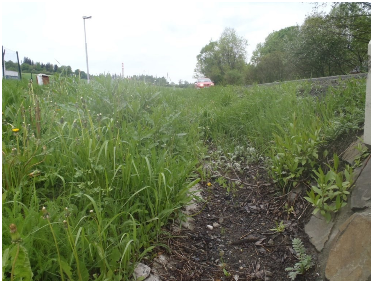
Obrázek 30: Zanesení příkopů
