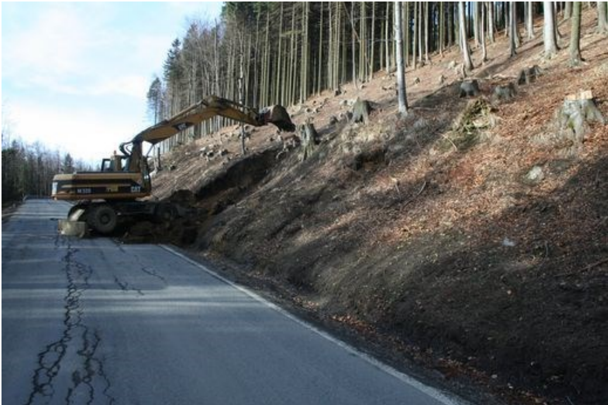
Obrázek 20: Výkop v trase (rozšíření prostoru PK)
