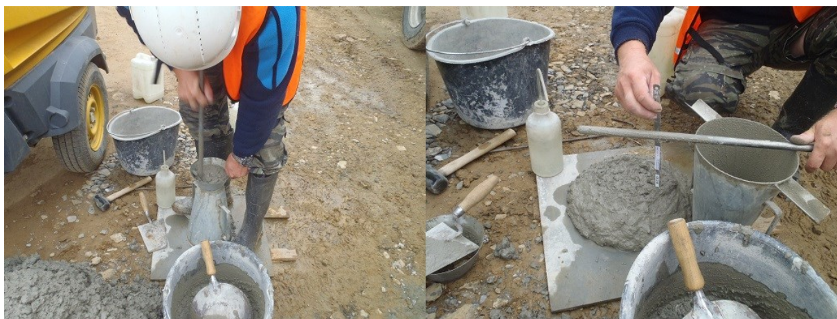
Obrázek 04: Stanovení konzistence čerstvého betonu
