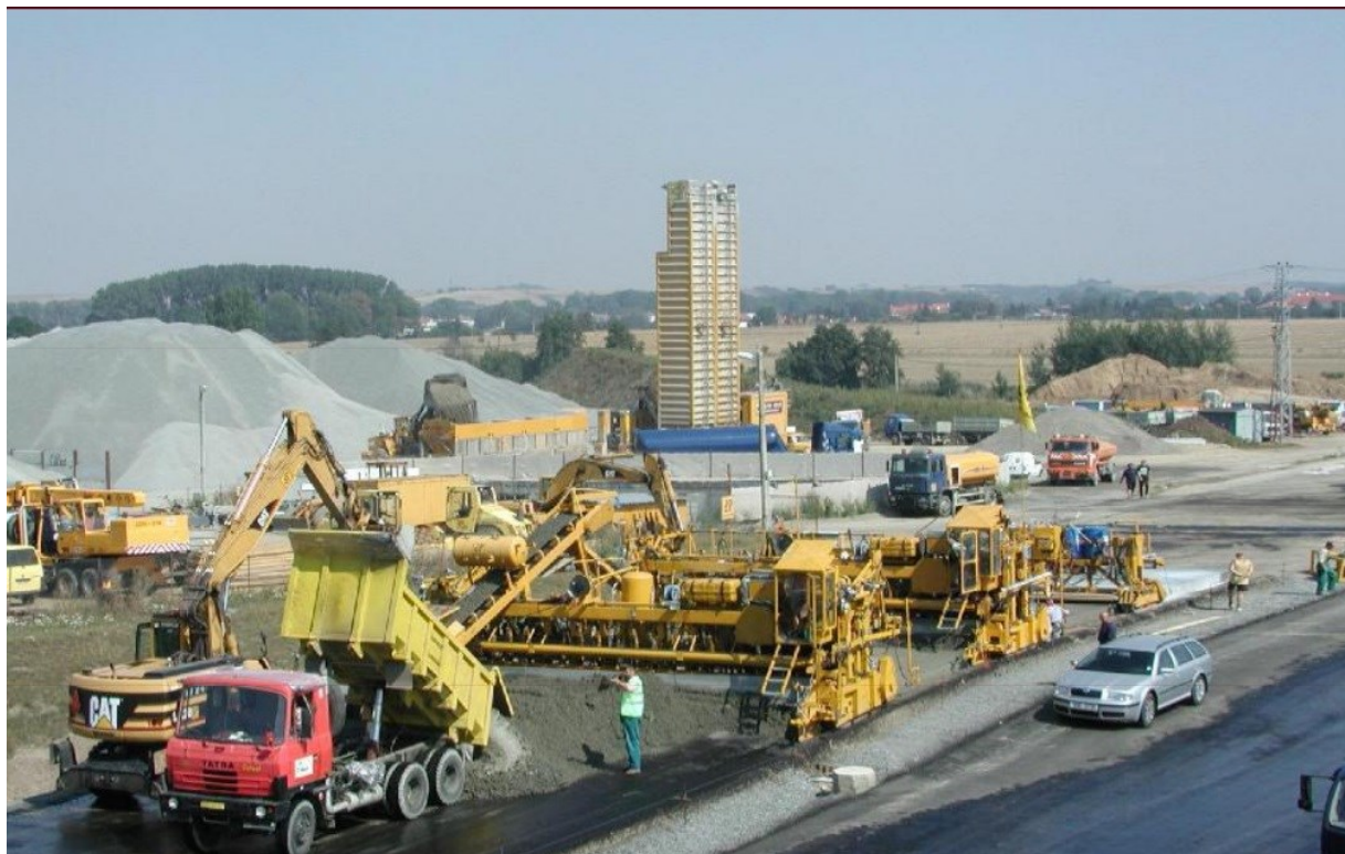
Obrázek 10: Pokládka dvouvrstvého CB krytu (zdroj A. Trinner)
