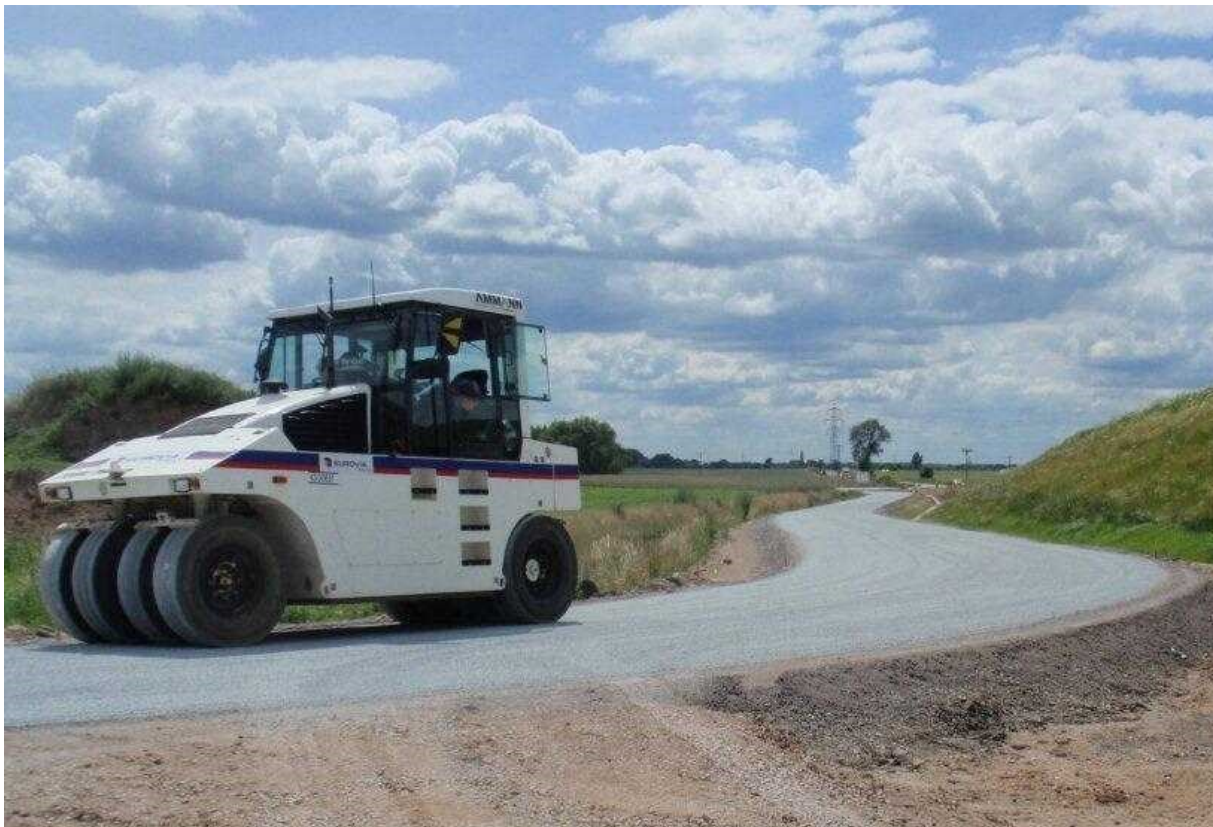
Obrázek 46: Jednovrstvý nátěr - zaválcování kameniva pomocí pneumatikového válce
