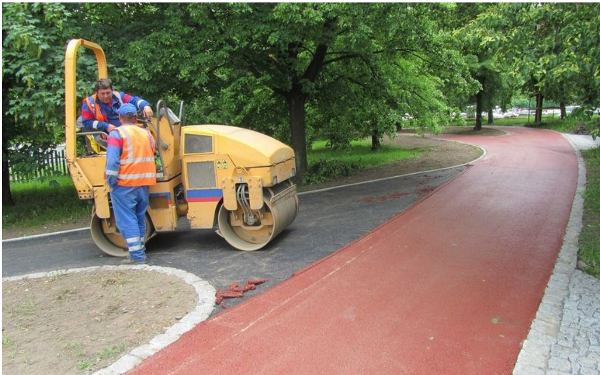
Obrázek 02: Pokládka barevného koberce BBTM 8A+, v tloušťce 20 mm
