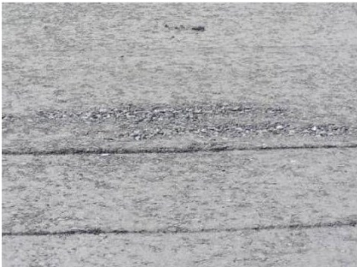
Obrázek 07: Segregace nestmelené směsi v podkladní vrstvě MZK (D. Stehlík, VUT-Brno)
