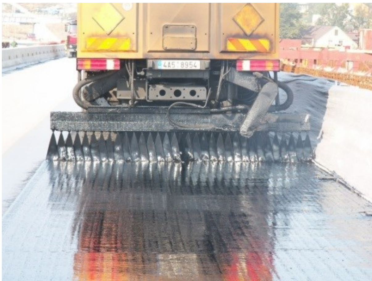
Obrázek 43: Distributor při stříkání membrány
