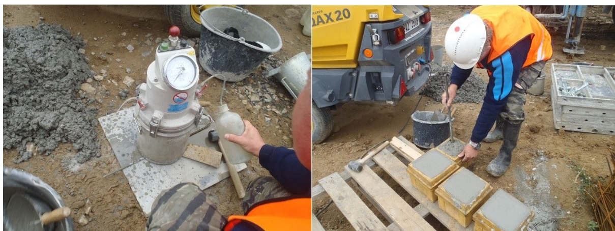
Obrázek 05: Stanovení obsahu vzduchu v čerstvém betonu a příprava vzorků pro zkoušení ztvrdlého betonu
