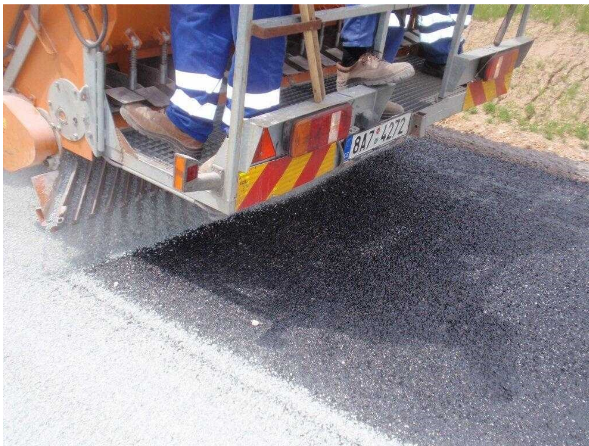
Obrázek 45: Detail při provádění podrt'ování jednovrstvého nátěru
