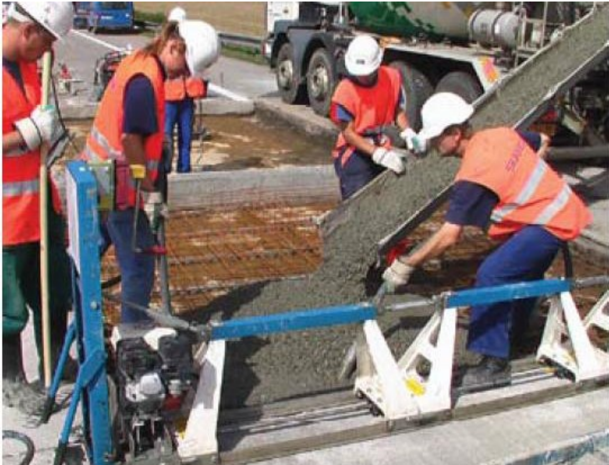
Obrázek 03: Betonáž nové CB desky pomocí „rychlých betonů“
