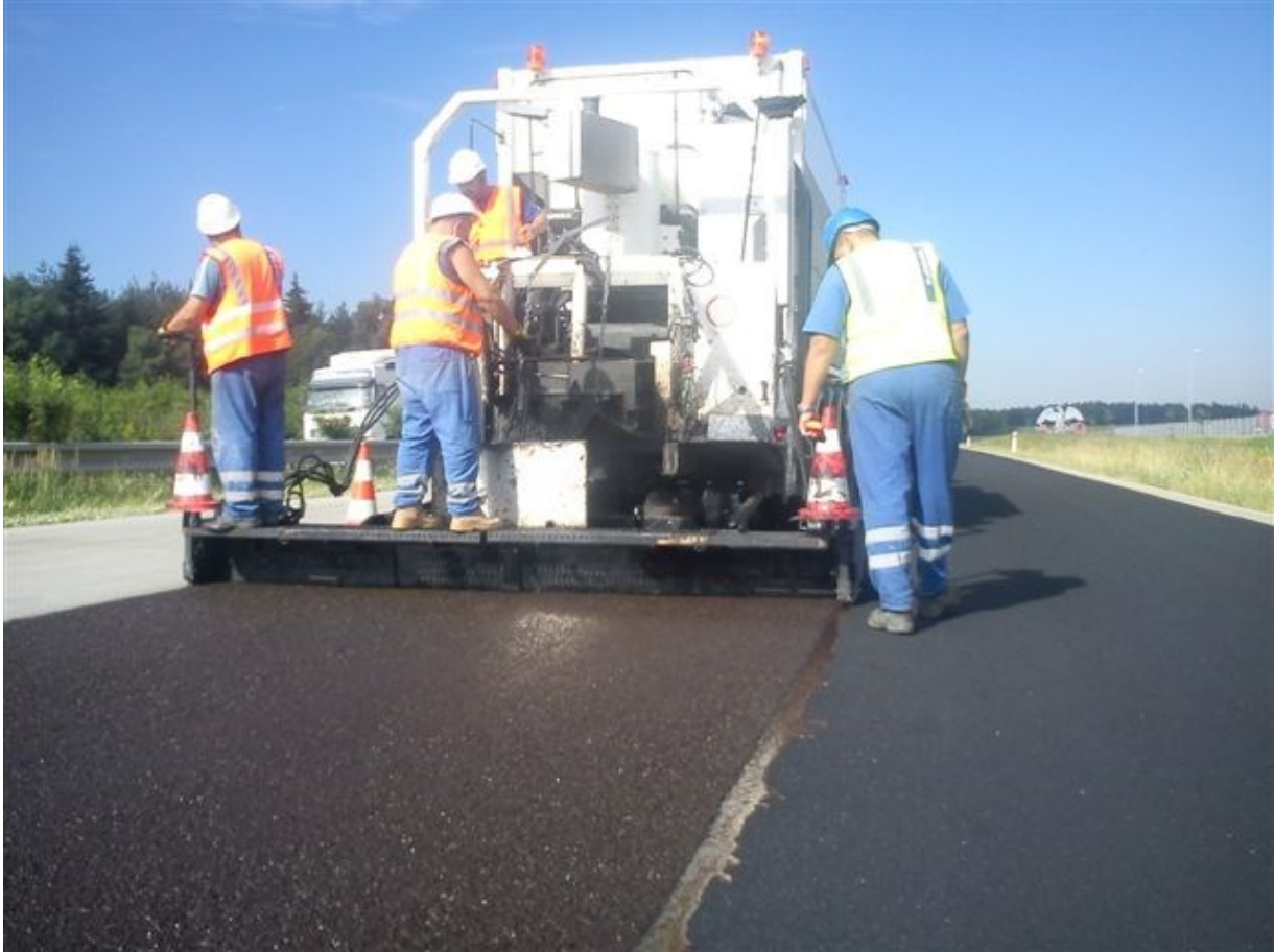
Obrázek 50: Vlevo probíhá pokládka čerstvého mikrokoberce (hnědá barva), vpravo již vyštěpená zkonsolidovaná vrstva
