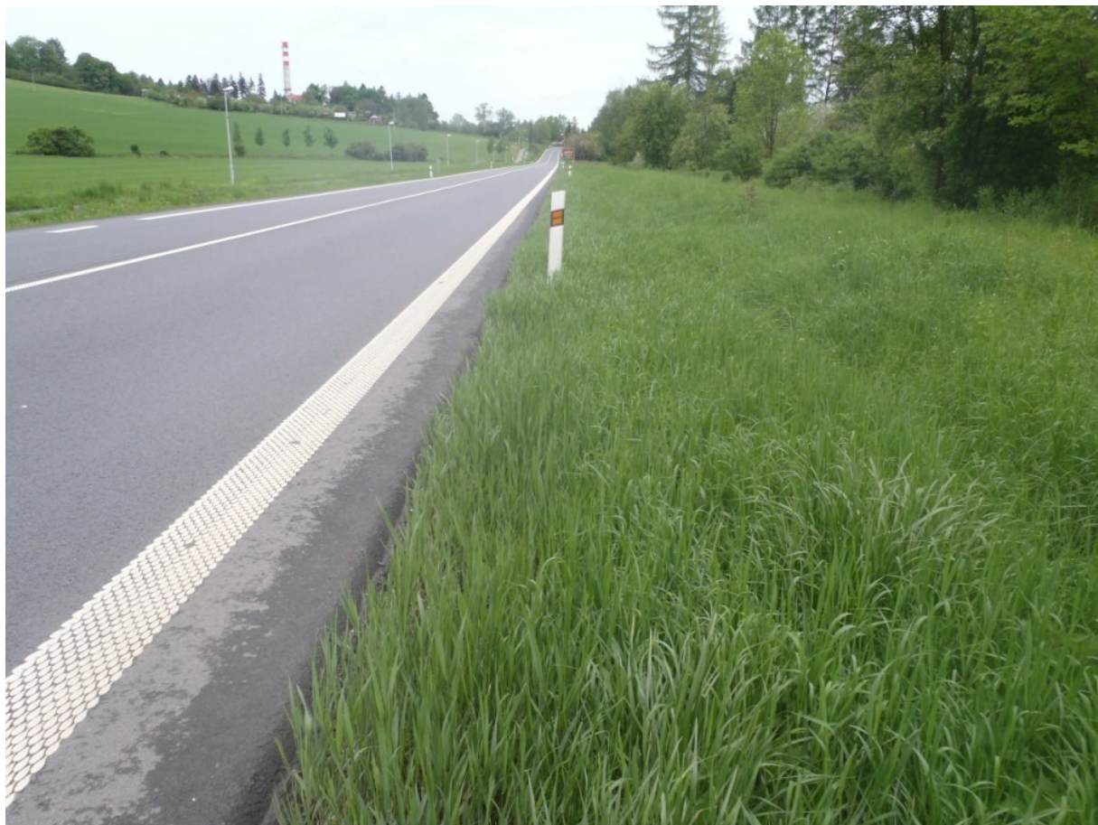
Obrázek 31: Zvýšená nezpevněná krajnice
