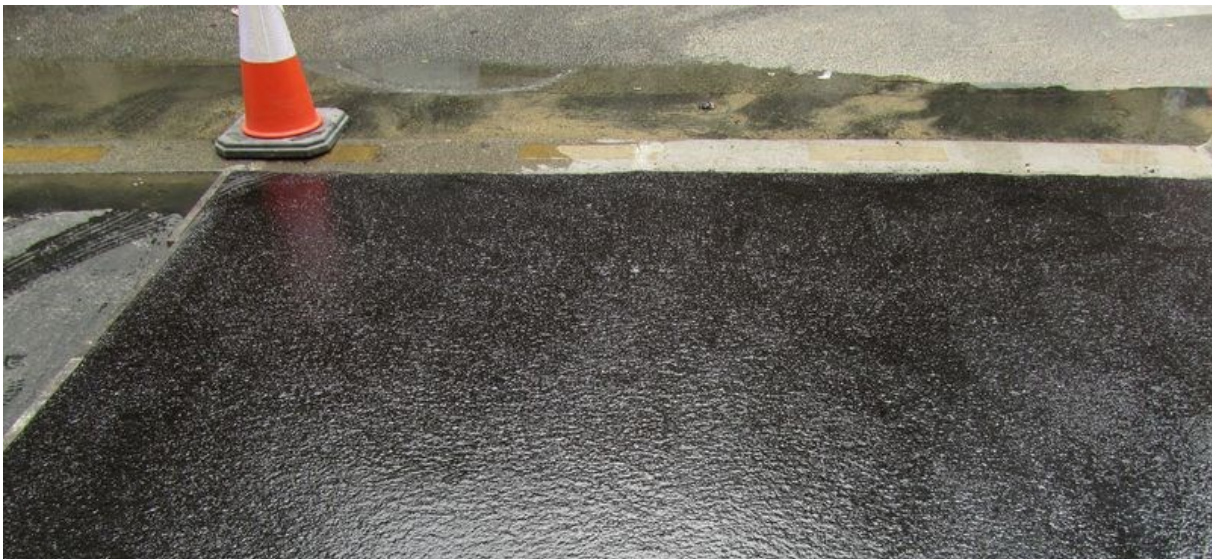
Obrázek 04: Povrch čerstvě položeného litého asfaltu
