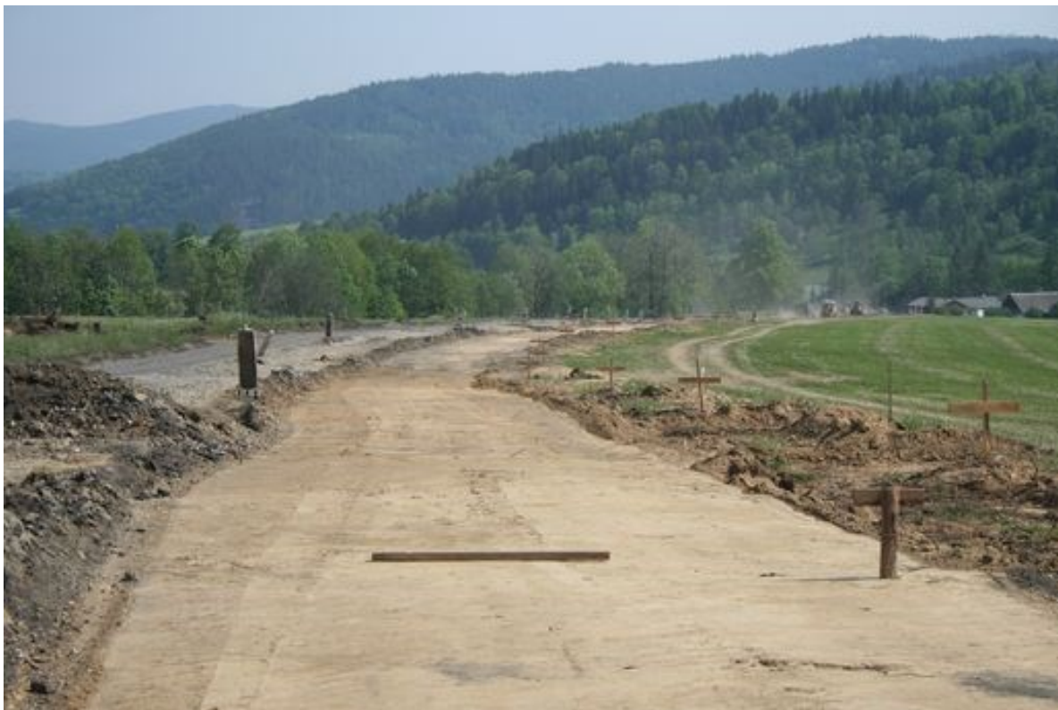
Obrázek 19: Výškové a polohové vytýčení
