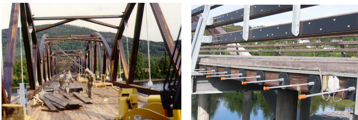
Fig. 11 Układanie pokładuy mostu Evenstad (foto: Moelven Limtre) oraz detal mostu Måsør (foto: K. Bell)
