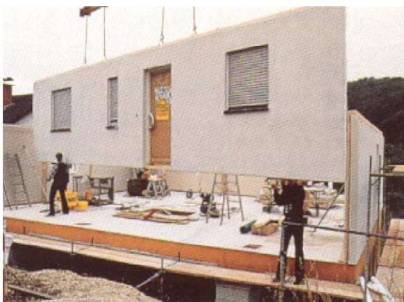
b. Montaż ściany na budowie
