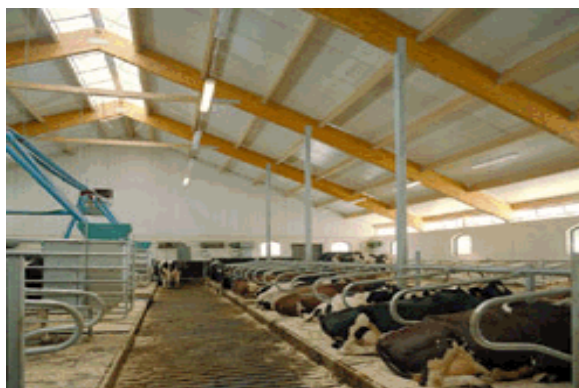
Fig. 10 Przykład ram trójprzegubowych (Za zgodą Svenskt Limträ AB)
