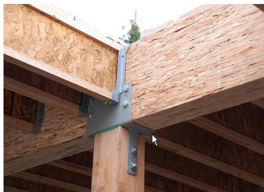
Fig. 4 LSL i ich zastosowanie jako belki
