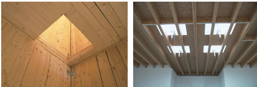
Fig. 32 Otwory na komin i uźebrowane elementy CLT ze świetlikami
