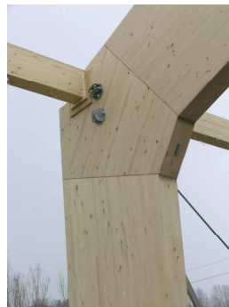
Fig. 5 Połączenia płyt sklejących (lameli) na wczepy klinowe i klejony narożnik ramy
