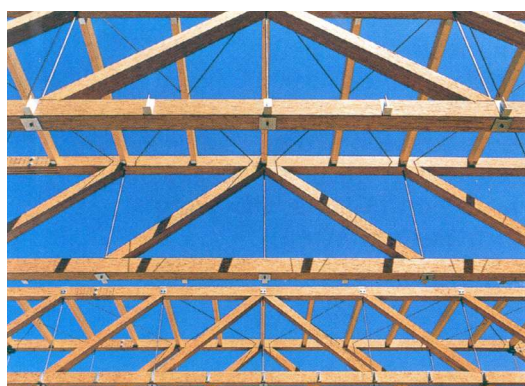
Fig. 5 Parallam i jego zastosowanie w wiązarze dachowym
