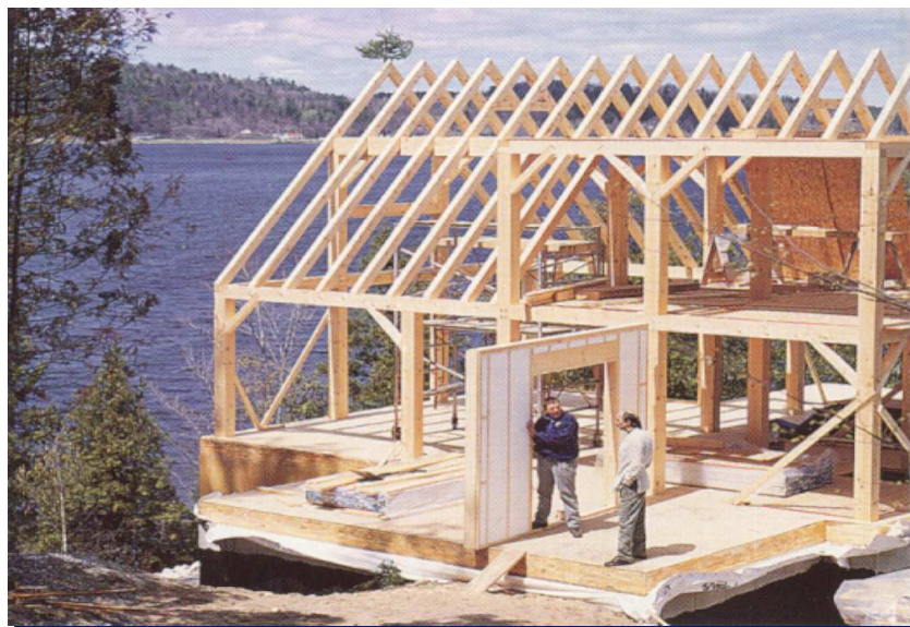
Fig. 1 System belkowo-słupowy
