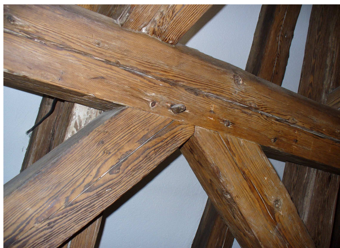
Fig. 6 Połączenia ciesielskie
