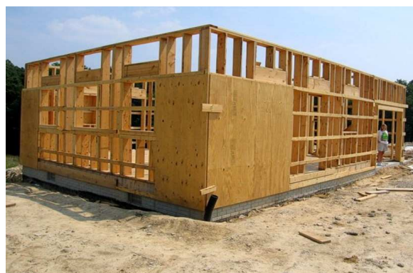
Fig. 6 Sklejka 9-o warstw. (robinia) i zast. sklejki jako poszycie usztywniające ścian szkieletowych
