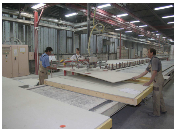
a. Montaż ściany prefabrykowanej
