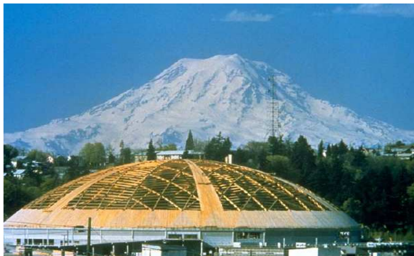
Fig. 6 Konstrukcja wsporcza Tacoma Dome w USA (z: internet)
