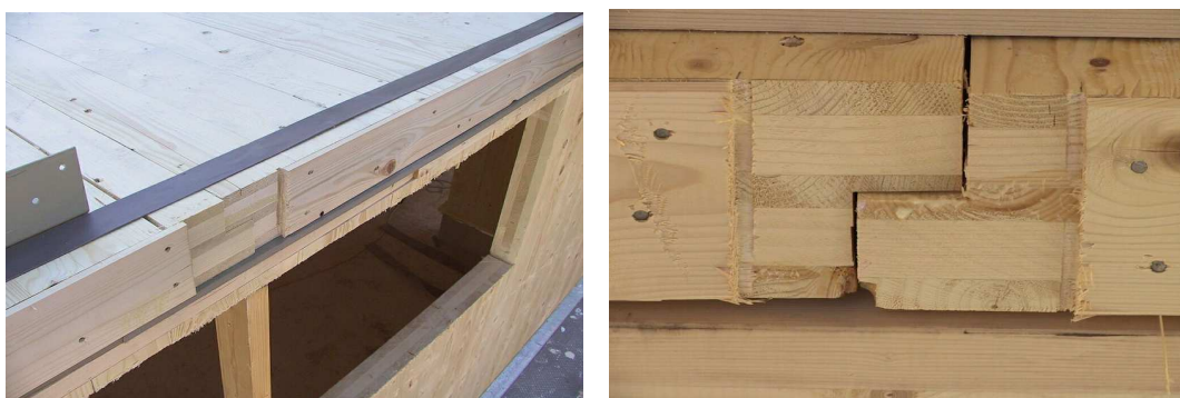
Fig. 38 Połączenie podłoga-podłoga
