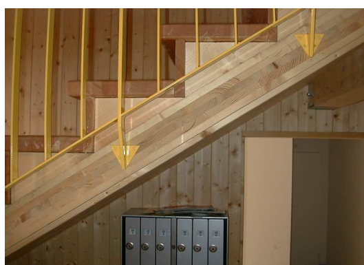
Fig. 31 Element klatki schodowej
