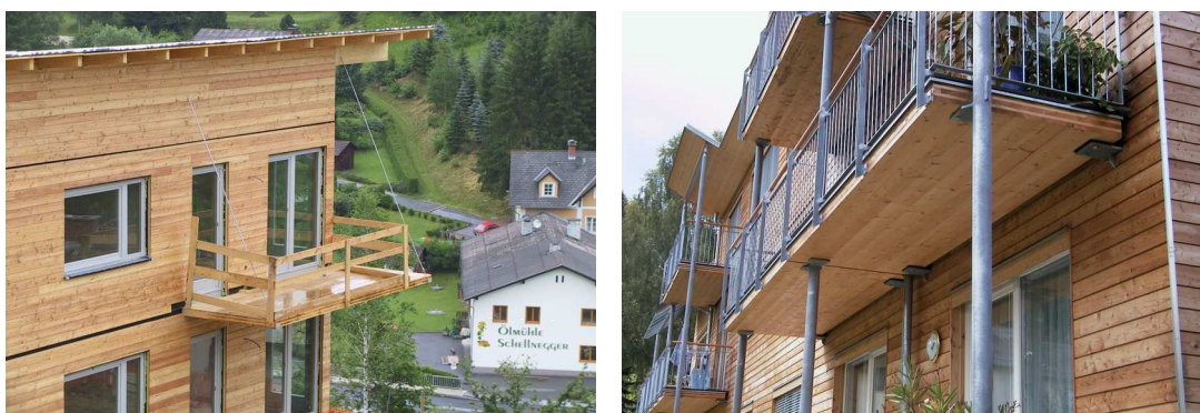
Fig. 33 Wspornikowe i punktowo podparte płyty balkonowe
