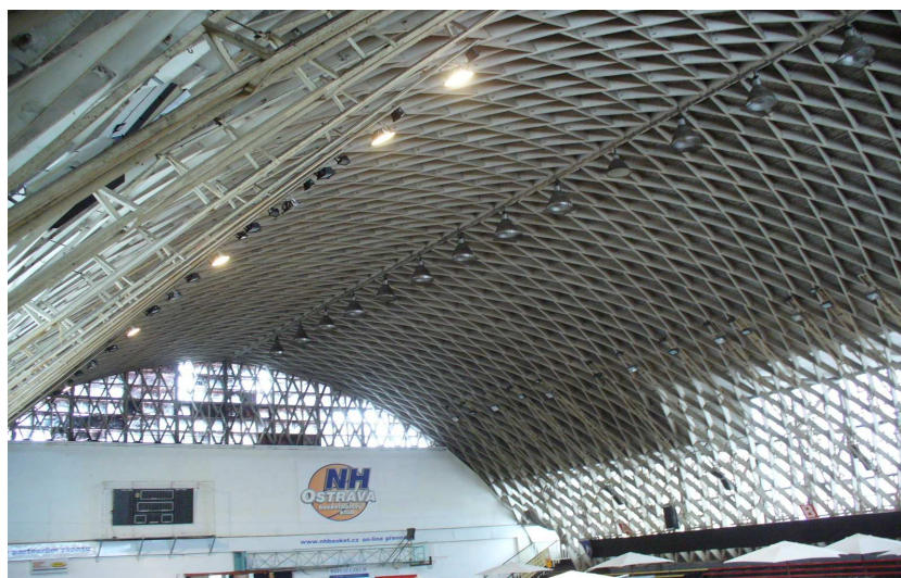
Fig. 1 Sklepienie lamelowe dachu hali sportowej
