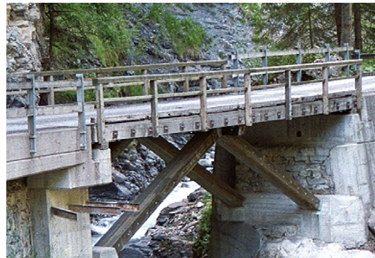
Fig. 9 Płyty BRESTA; Poprzecznie sprężony pokład drewniany mostu.
