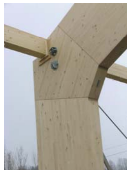
Obr. 5 Klinový spoj lamiel v LLD a vlepovaný rámový roh
