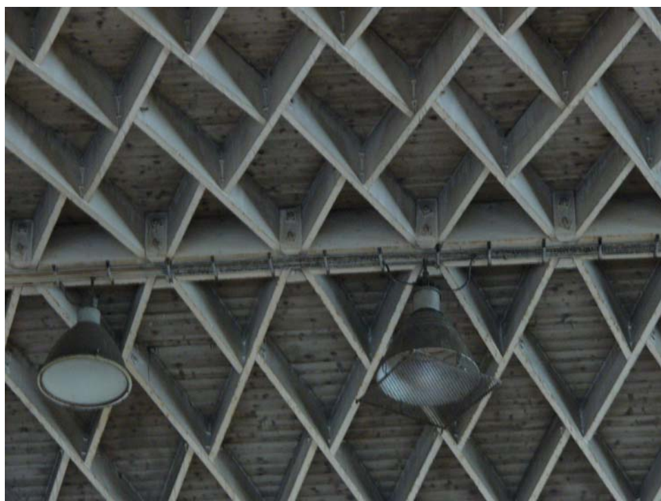
Obr. 2 Detail spojení lamel klenby sportovní haly
