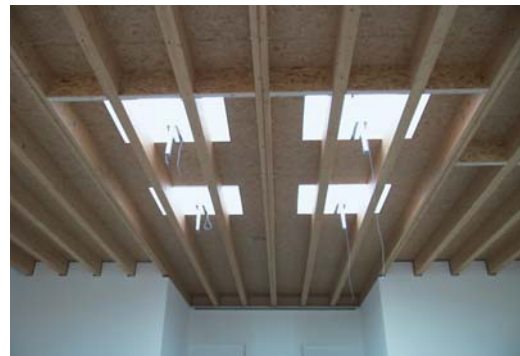
Obr. 32 Otvor pre komín a trámový CLT- element so svetlíkmi
