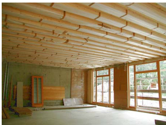
Obr. 34 Trámový strop s použitím CLT- elementov
