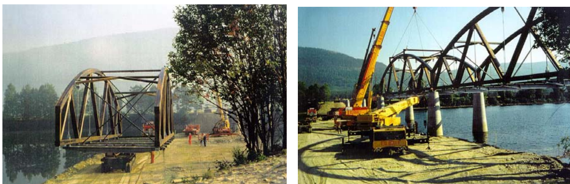
Obr. 18 Montáž mosta Evenstad v roku 1996 (Foto: Moelven Limtre AS)
