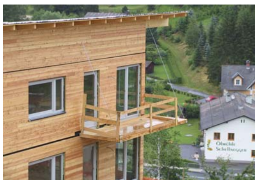
Obr. 33 Balkónové dosky – konzola (vľavo) a bodovo podopretá doska (vpravo)
