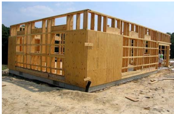
Obr. 6 9-vrstvová agátová preglejka a použitie preglejok ako výstužných prvkov drevostavby
