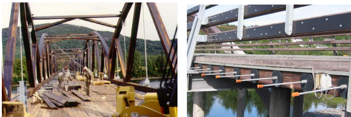
Obr. 12 Pokládka mostovky mosta Evenstad (Foto: Moelven Limtre) a detail mosta Måsør (Foto: K. Bell)
