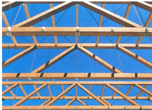
Obr. 5 Parallam a jeho použitie ako ťahaný prút priehradového väzníka
