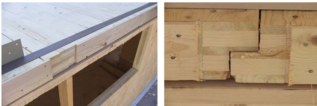
Obr. 38 Spoj stropná doska – stropná doska
