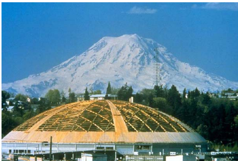
Obr. 6 Nosná konstrukce zastřešení Tacoma Dome v USA (zdroj: Internet)
