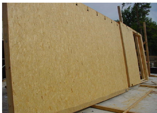
Obr. 3 OSB a jej použitie ako nosný obkladový materiál v stĺpkovej konštrukcii
