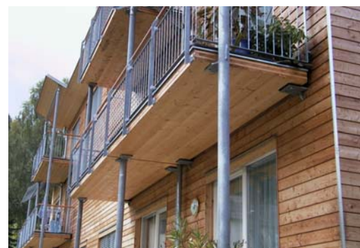
Obr. 33 Balkónové dosky – konzola (vľavo) a bodovo podopretá doska (vpravo)
