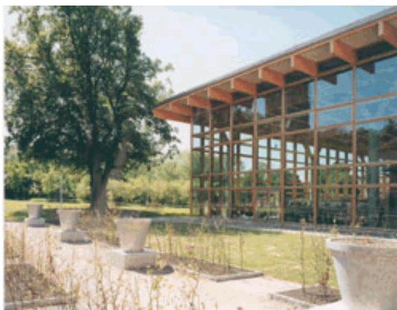
Obr. 8 Nosníky z LLD v budove knižnice, Švédsko (Zobrazené s povolením Svenskt Limträ AB)
