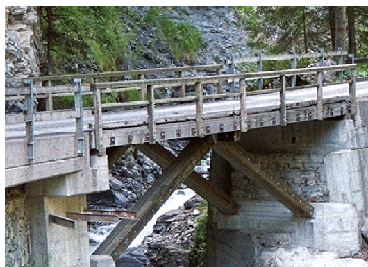
Obr. 9 Nastojato uložené dosky spojené mechanickými spojovacími prostriedkami (BRESTA); priečne predpätá drevená mostovka
