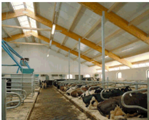
Obr. 10 Trojklbová sústava pre maštal' vo Švédsku (Zobrazené s povolením Svenskt Limträ AB)
