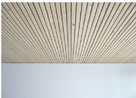
Obr. 9 Nastojato uložené dosky spojené mechanickými spojovacími prostriedkami (BRESTA); priečne predpätá drevená mostovka
