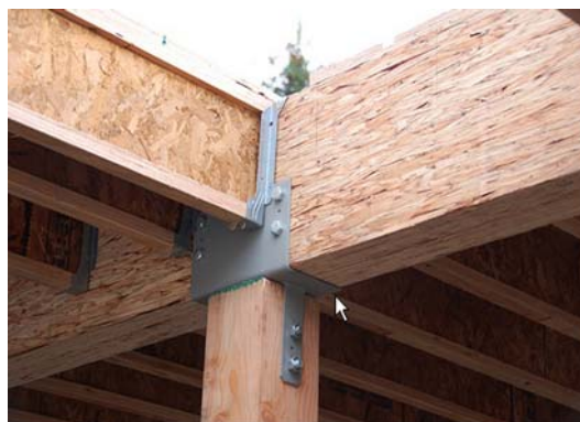
Obr. 4 LSL a jeho použitie ako nosník
