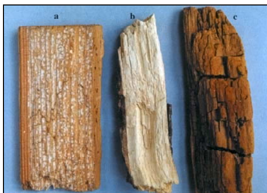
Obr. 2 Poškození houbami: částečné poškození bílou hnilobou (a), plné poškození bílou hnilobou (b), poškození hnědou hnilobou (c) [2].
