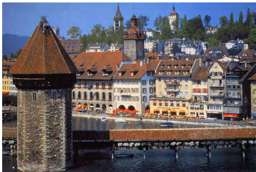
Abb. 1.19 Kapellbrücke in Luzern
