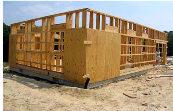
Abb. 6.6 9-lagiges Sperrholz (Robinie) und Verwendung von Sperrholz als Beplankungsmaterial in einer Holzrahmenwandkonstruktion
