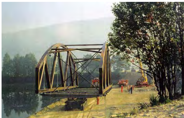
Abb. 15.18 Montage der Evenstad-Brücke im Jahre 1996 (Photos: Moelven Limtre AS)
