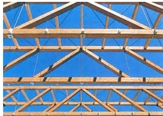
Abb. 6.5 Parallam und seine Verwendungen als stabförmiges Produkt als Zuggurt eines Fachwerks
