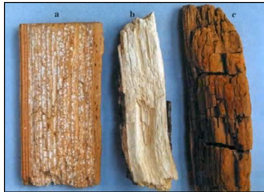
Abb. 16.2 Holzabbau durch Pilze: teilweise Weißfäule (a), Weißfäule (b), Braunfäule (c) [2].
