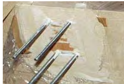
eingeklebte Gewindestangen (vorwiegend auf Abscheren beansprucht)
