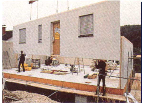
b. Montage einer Wand in Tafelbauweise auf der Baustelle
