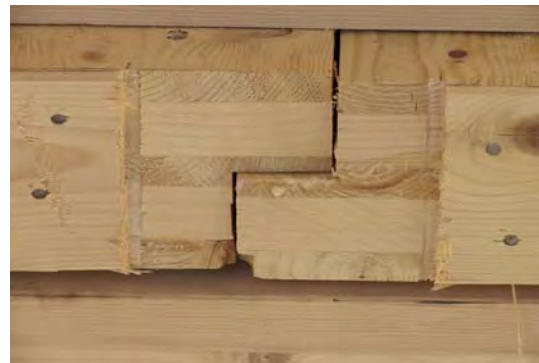
Abb. 6.38 ausgeführte Decke-Decke-Verbindung (Stufenfalz)
