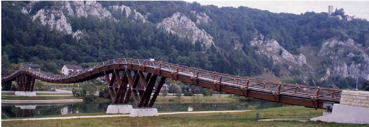
Abb. 15.1 Fußgängerbrücke über den Rhein-Main-Donau-Kanal in Essingen, Deutschland (Photo: J. Sivertsen)
