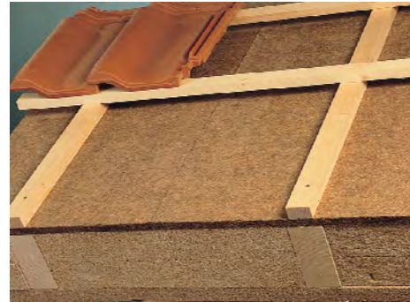
Verwendung von Faserplatten in einer Dachkonstruktion
