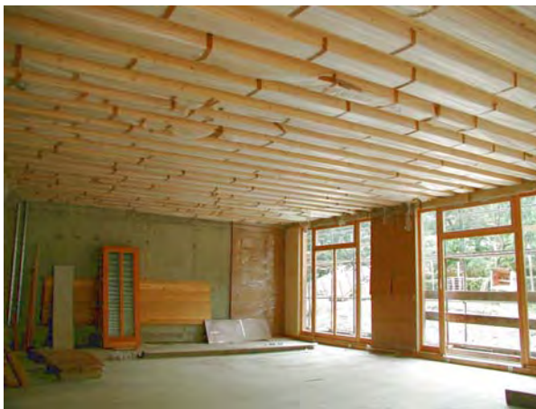
Abb. 6.34 Aus BSP- Elementen aufgebaute Rippenplatte und Kastenquerschnitt
