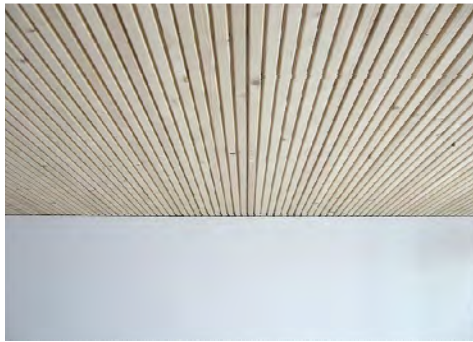
Abb. 6.9 Brettstapelelement mit vertikal ausgerichteten Brettlagen (BRETTA-V) in einer Decke und quervorgespanntes Fahrbahndeck einer Brücke
