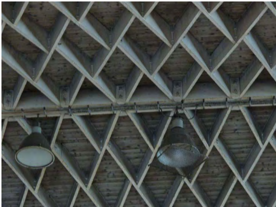
Abb. 12.2 Detail einer Lamellenverbindung am Gewölbe der Sporthalle
