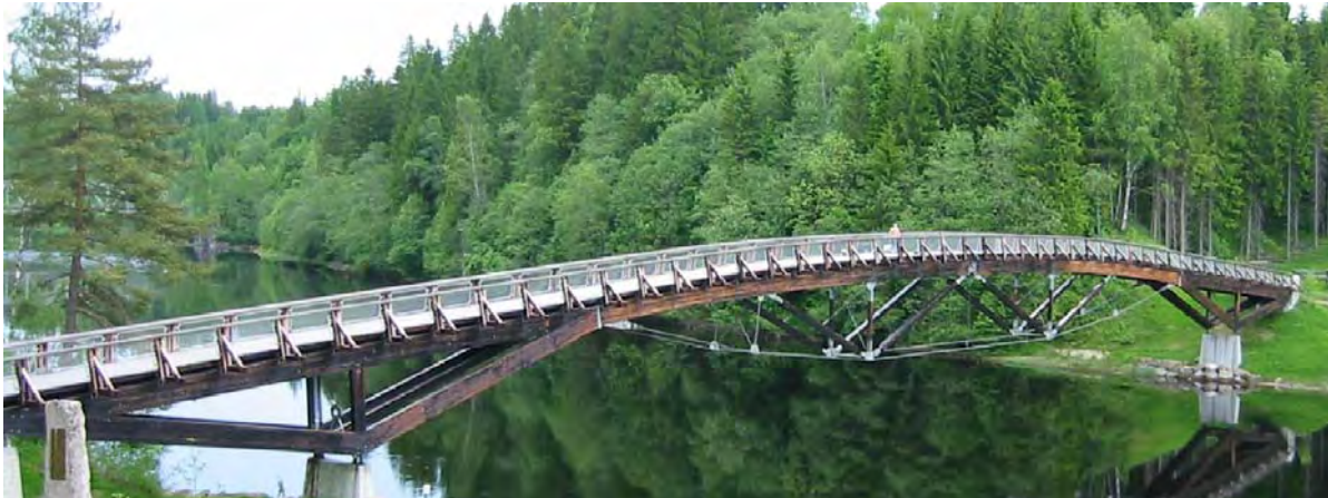
Abb. 15.3 Fußgängerbrücke in Lardal, Norwegen (Photo: A. Rönquist)
