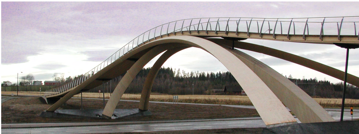
Abb. 15.2 Leonardo-Fußgängerbrücke in Ås, im Süden von Oslo, Norwegen (Photo: Moelven Limtre AS)
