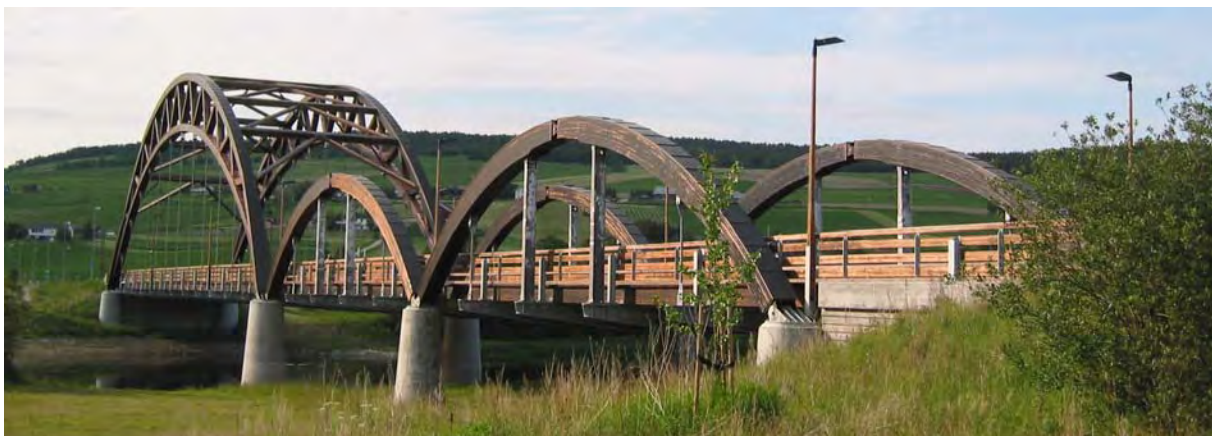
Abb. 15.6 Tynset-Brücke, Norwegen (Photo: K.Bell)
