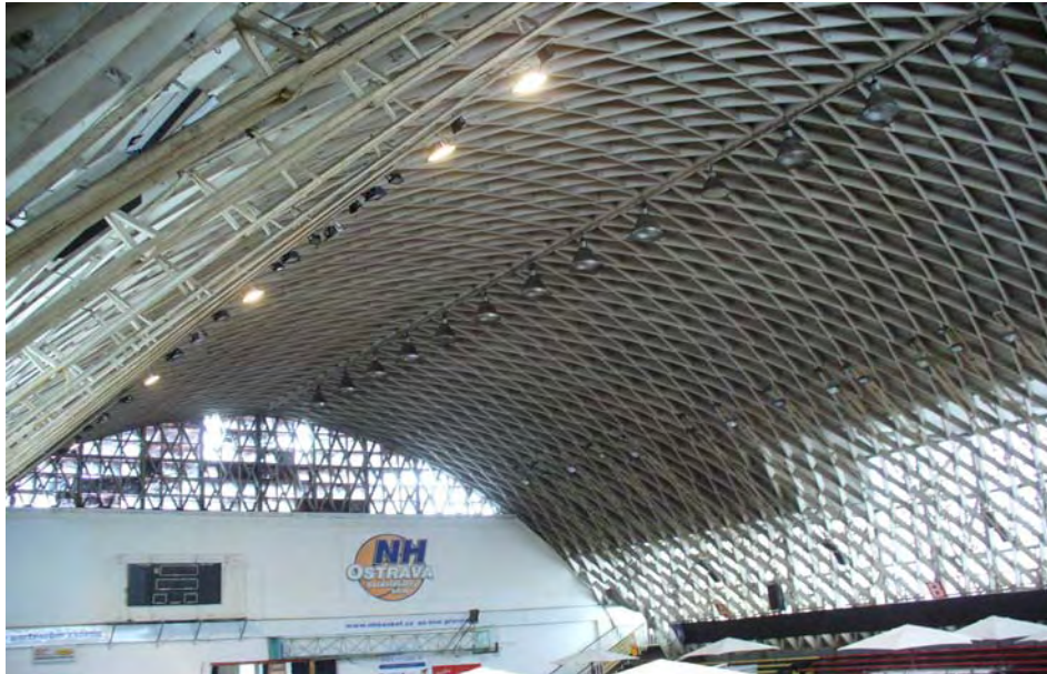
Abb. 12.1 Lamellengewölbe des Sporthallendachs
