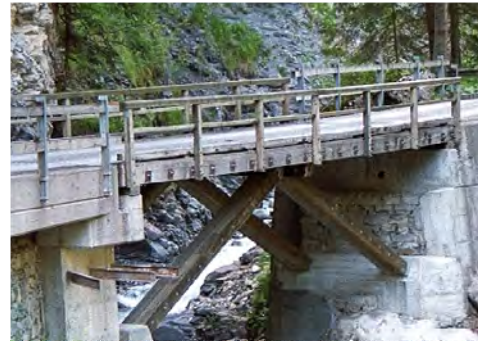
Abb. 6.9 Brettstapelelement mit vertikal ausgerichteten Brettlagen (BRETTA-V) in einer Decke und quervorgespanntes Fahrbahndeck einer Brücke
