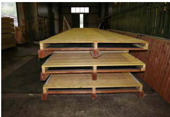
a. vorgefertigte Wandelemente mit Schalung
