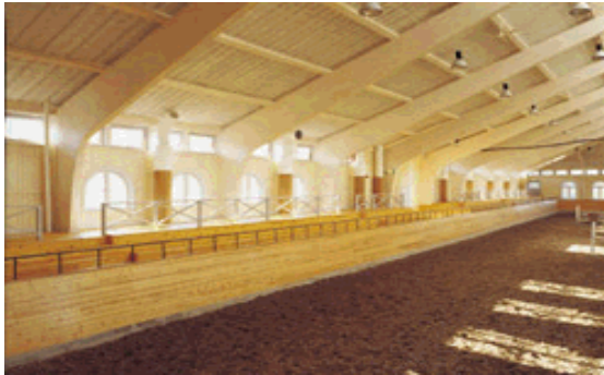
Abb. 5.12 Rahmen in einer Reitschule in Schweden (Photo: Svenskt Limträ AB)
