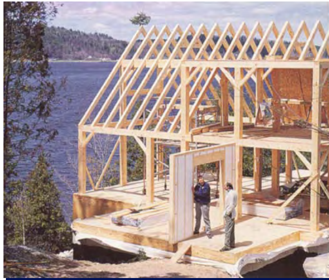
Abb. 13.1 Beispiel für einen Holzskelettbau
