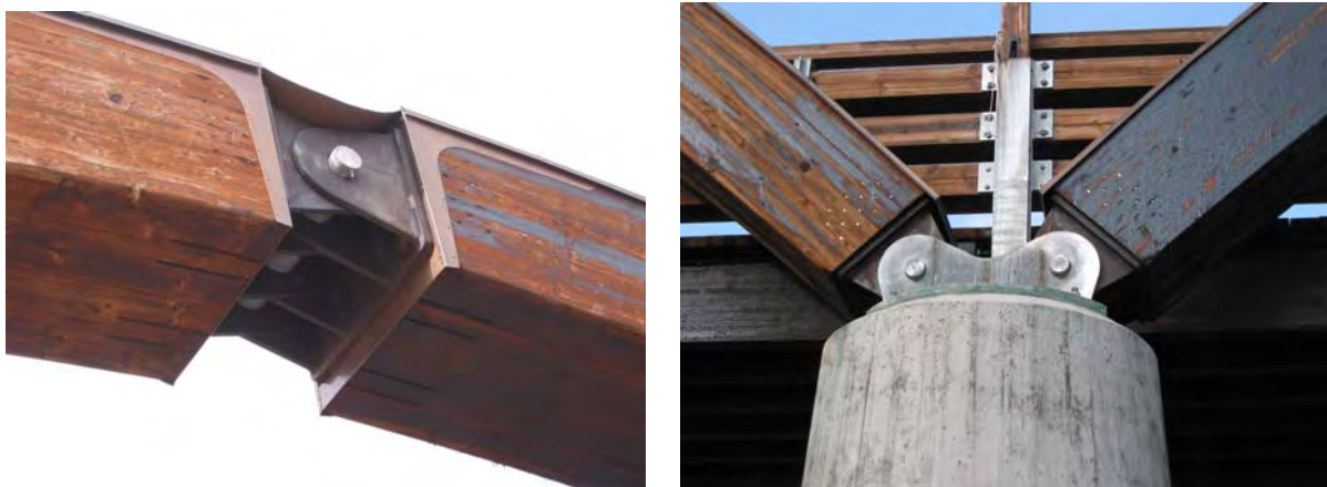
Abb. 15.14 Details der Tynset-Brücke (Photo: K. Bell)
