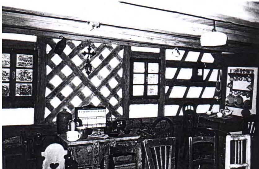
Abb. 1.11 Wand mit einem zimmermannsmäßigen Fachwerk
