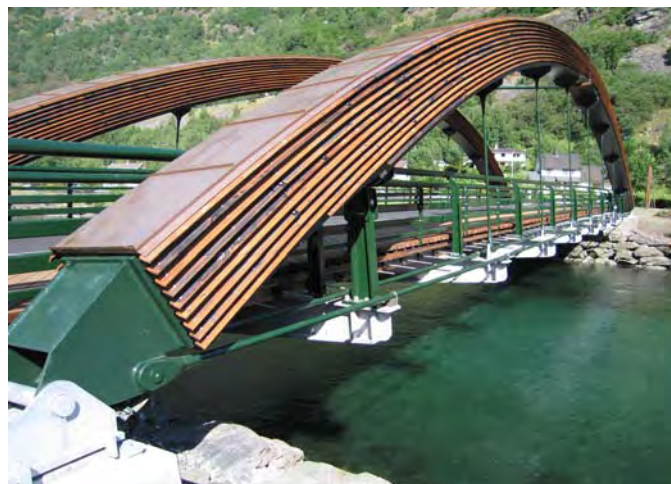
Abb. 15.17 Fretheim-Brücke in Flåm im Westen Norwegens (Photo: R. Abrahamsen, SWECO Grøner AS)
