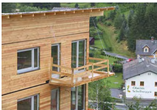
Abb. 6.33 Freitragende und punktgelagerte Balkonplatten
