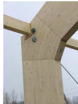
Abb. 10.5 Keilzinkenverbindung einer Brettschichtholzlamelle und geklebtes Rahmeneck
