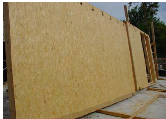
Abb. 6.3 OSB und seine Anwendung als lastabtragendes Beplankungsmaterial in einer Wandscheiben
