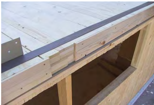
Abb. 6.38 ausgeführte Decke-Decke-Verbindung (Stufenfalz)
