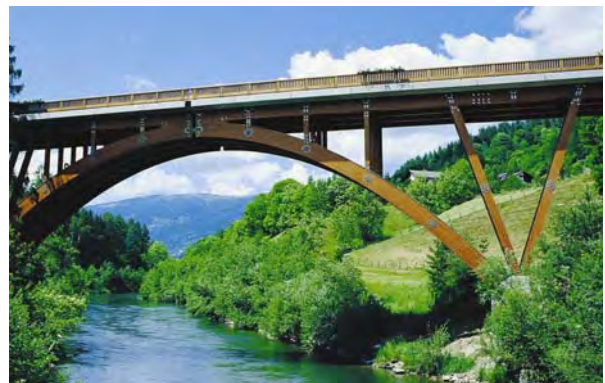
Abb. 5.7 Europabrücke in Murau, Österreich (Photo: Josef Bärnthaler)
