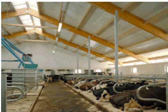
Abb. 5.10 Dreigelenkrahmen in einem schwedischen Stall (Photo: Svenskt Limträ AB)
