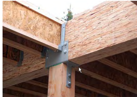
Abb. 6.4 LSL und seine Verwendung als stabförmiges Produkt (Träger)
