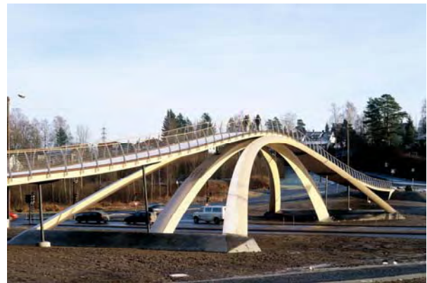
Abb. 5.5 Leonardo da Vinci Brücke in Ås, NO (Photo: Öffentliche Norwegische Straßenverwaltung)
