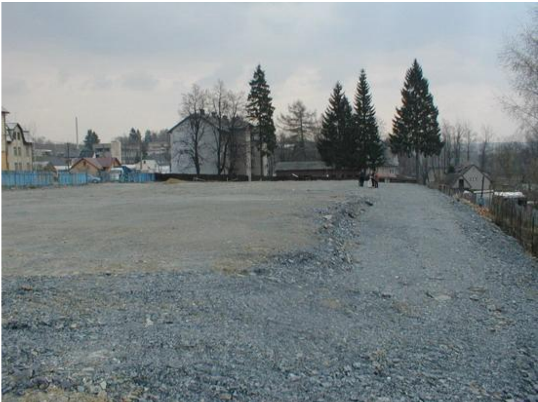
Úprava pláně (HTÚ)
