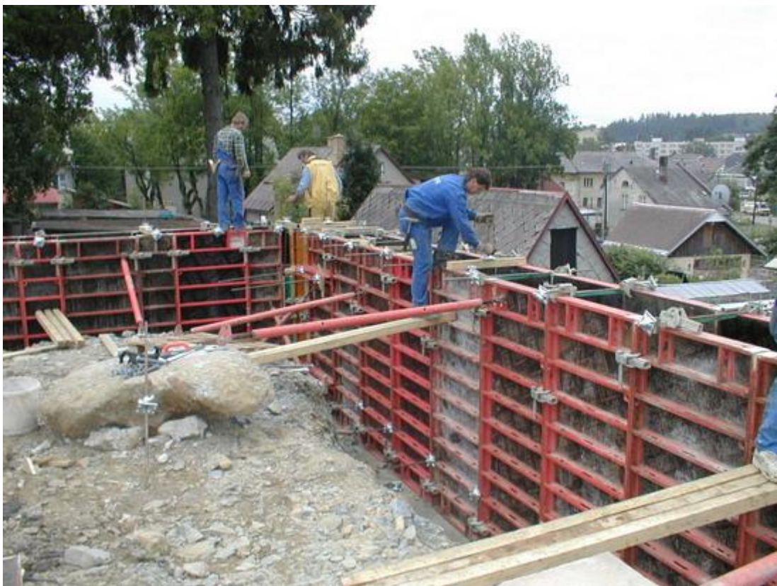
Bednění monolitické stěny na základovém pásu
