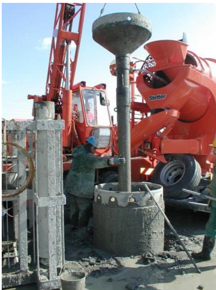
Betonáž velkopřůměrových pilot pod HPV
