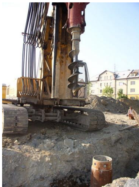
Vrtání pilot do ocelové výpažnice
