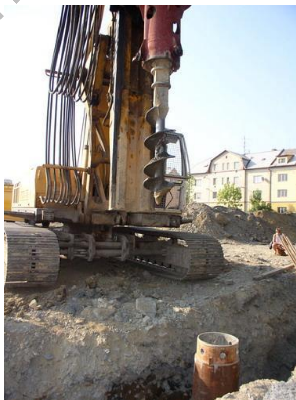
Vrtání pilot do ocelové výpažnice
