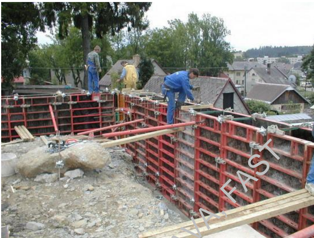
Bednění monolitické stěny na základovém pásu
