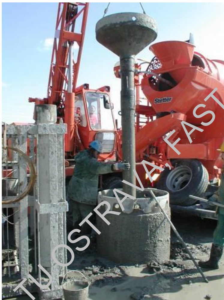
Betonáž velkopřůměrových pilot pod HPV
